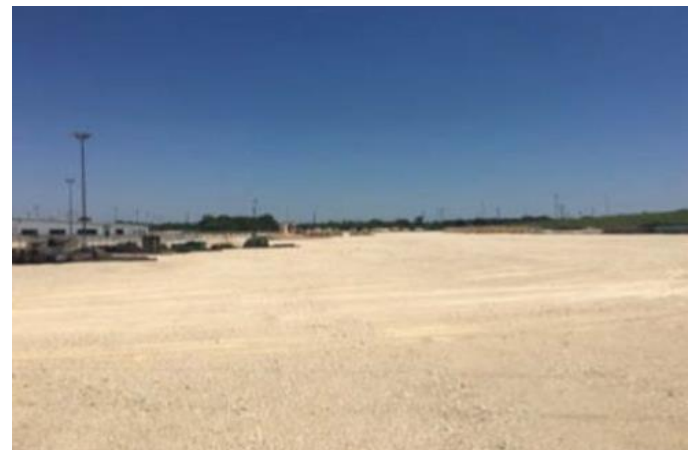
Site Laydown Area
